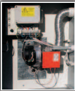
Box bruciatore Burner box
